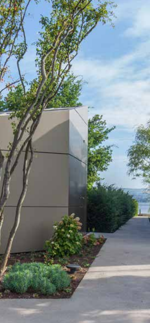
Beplankung unsichtbar befestigt
