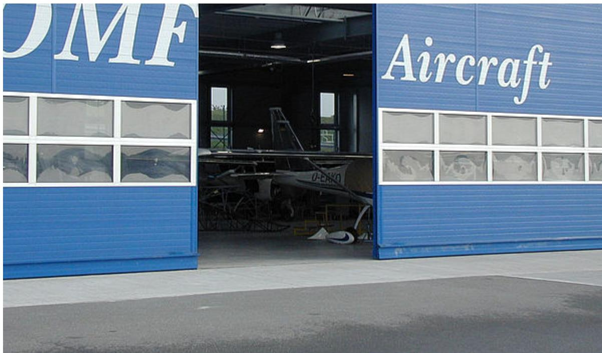
Die Tore überzeugen durch ihre **praktische und platzsparende Konstruktion**: Da sie seitlich geöffnet werden, bleibt die gesamte Durchfahrtshöhe erhalten – ein entscheidender Vorteil bei hohen Fahrzeugen, Maschinen oder Flugzeugen.
